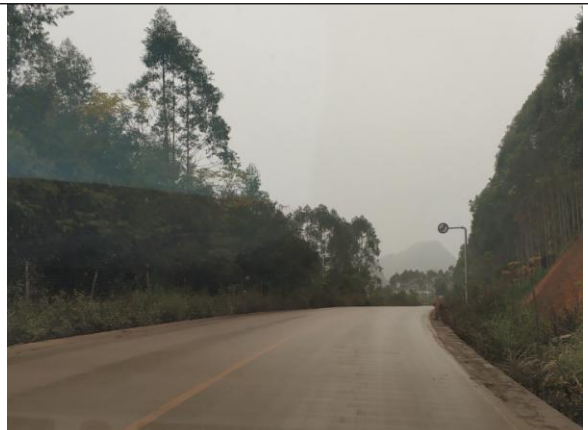
管线穿越二级公路现状
