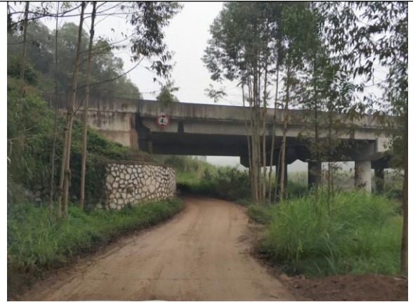
水厂进场道路现状
