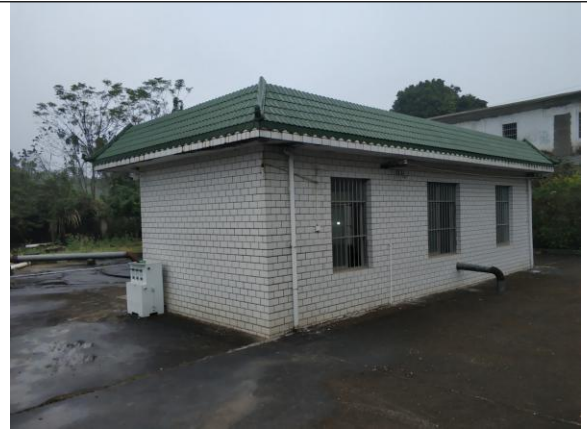
水厂现有泵房
