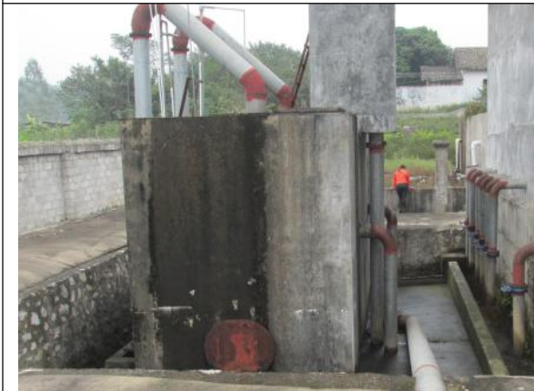
水厂现有滤池
