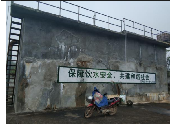
水厂现有沉淀池
