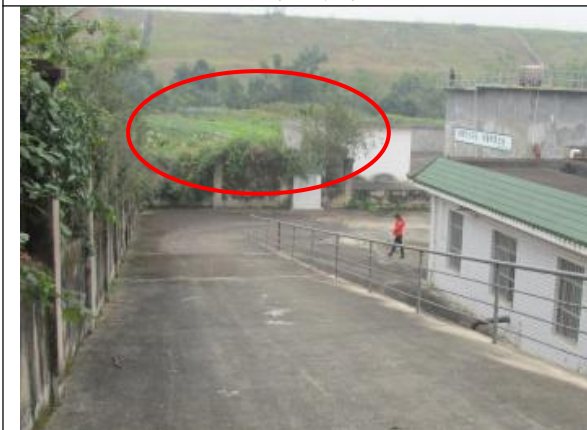
扩建区域现状
