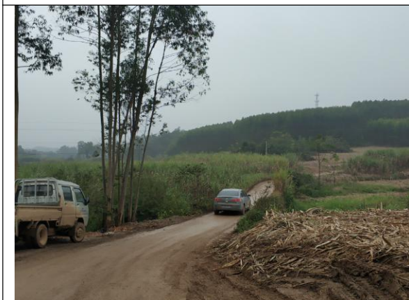
管线沿线村道现状
